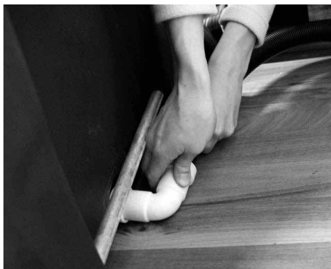
2. Démontage du tuyau d'évacuation
